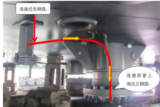
图 17: 上端法兰牵引钢丝绳走向
