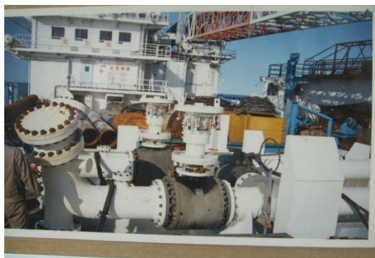
图3：水下基盘原始安装前照片
