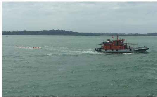
图 8：守护船拖运整条水下软管
