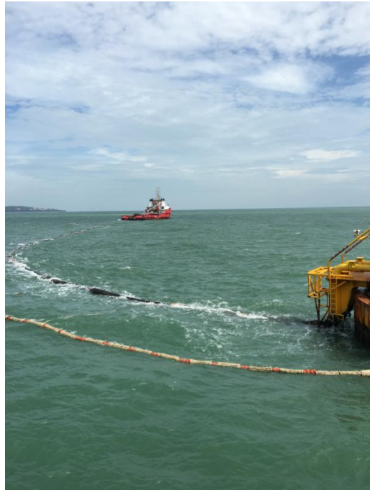
图 12：船舶拖拽漂浮软管
