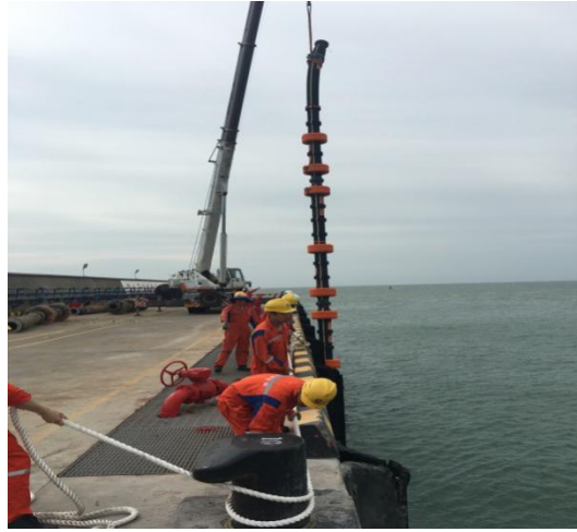
图 7：码头吊装到海面
