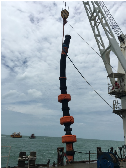
图 11：吊机起吊至最大高度
