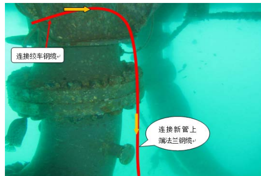
图 18: 上端法兰牵引钢丝绳走向
