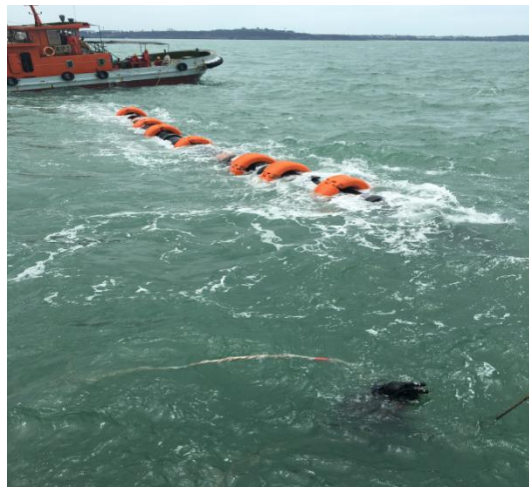
图 9：潜水员水面挂吊钩
