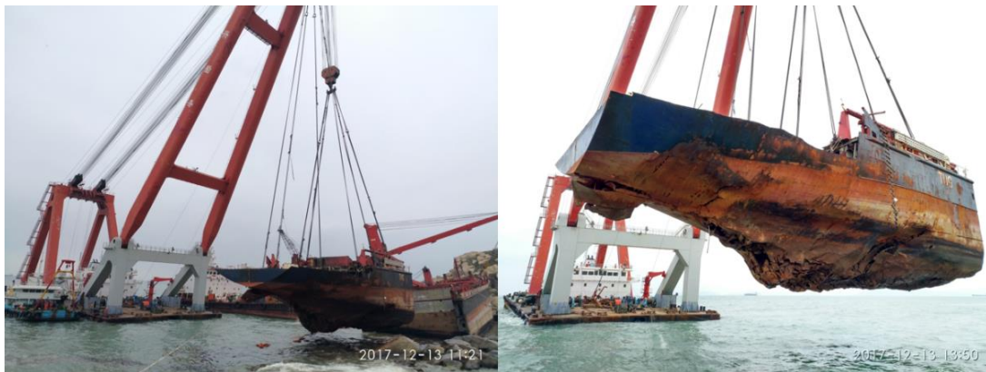
图13. 起吊难船机舱分段下部分
