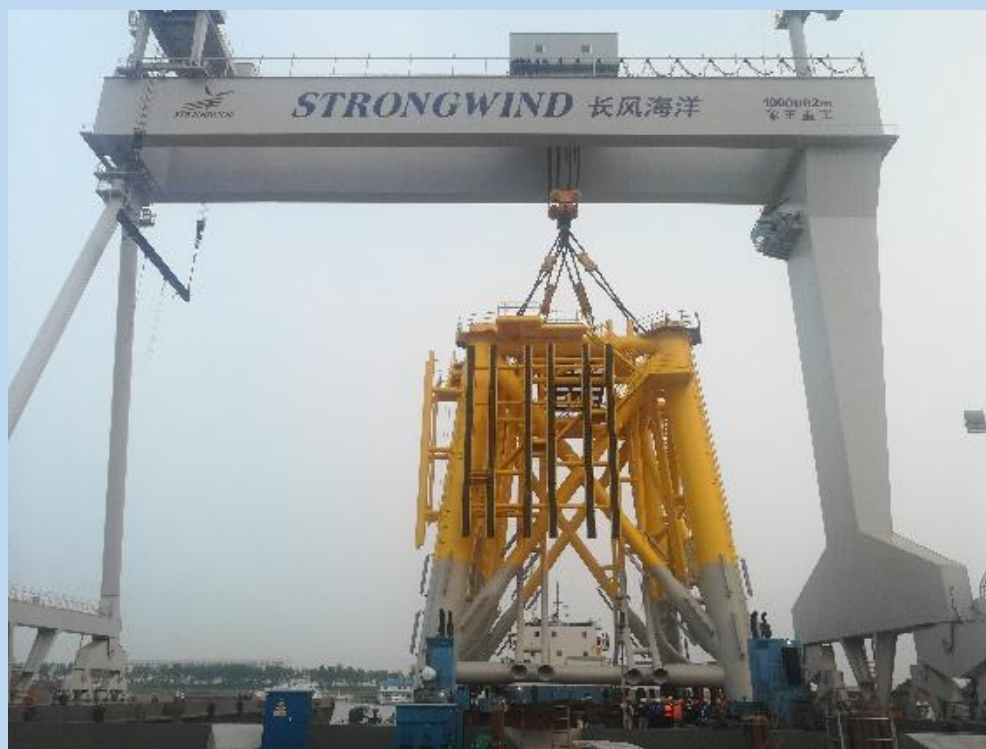
导管架码头吊装
