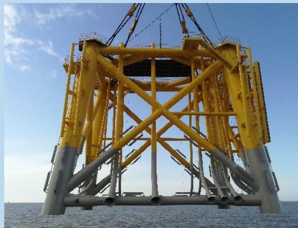
导管架海上吊装
